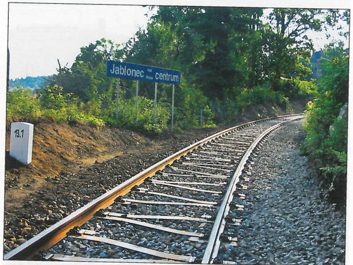
Pražce typu Y použité v roce 2010 na trati Jablonec nad Nisou - Smržovka.
