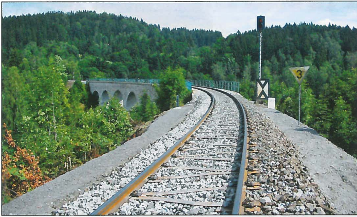
Instalace pražců Y z roku 2010 na viaduktu na trati Jablonec nad Nisou - Smržovka, v úseku Nová Ves - Paseky v km 20,900 - 21,996.
