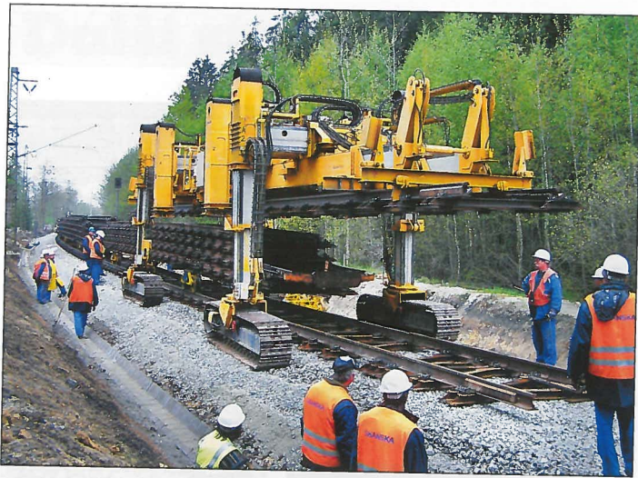
V roce 2005 byl úsek Popelín - Počátky-Žirovnice s Y-pražci prodloužen na délku 1 884 m. Při pokládce kolejových polí byl využit pokladač finské firmy Desec.
