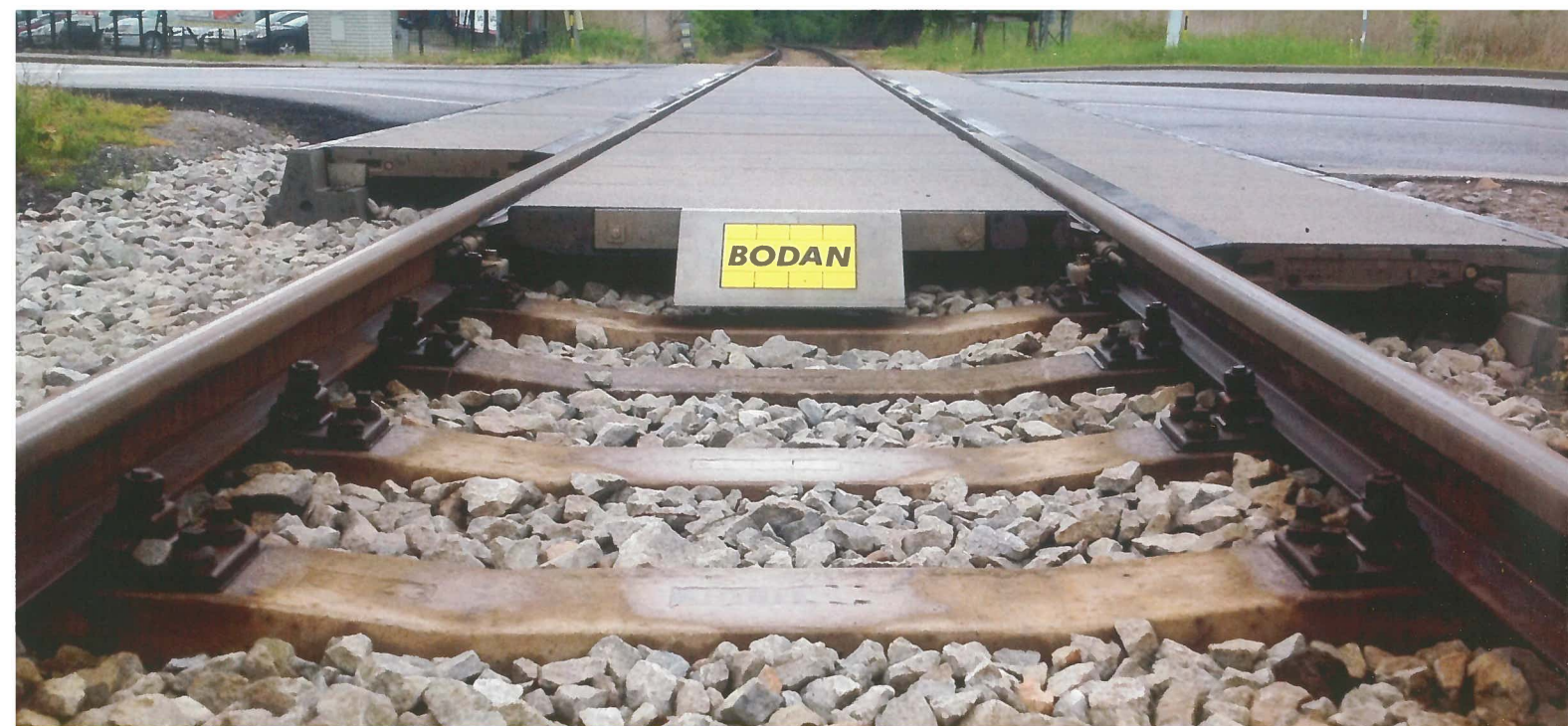
BODAN - přejezd v Klášterci nad Ohří, realizace
