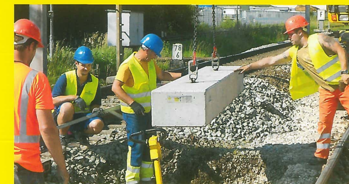
Pokládka základového trámce
