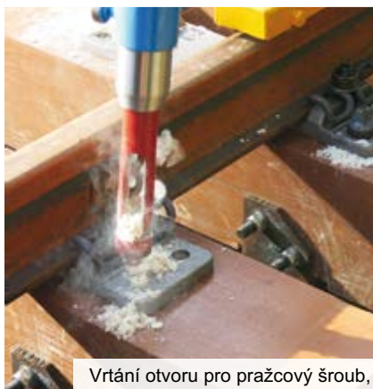
Vytesání, Zhotovení prohlubně,
