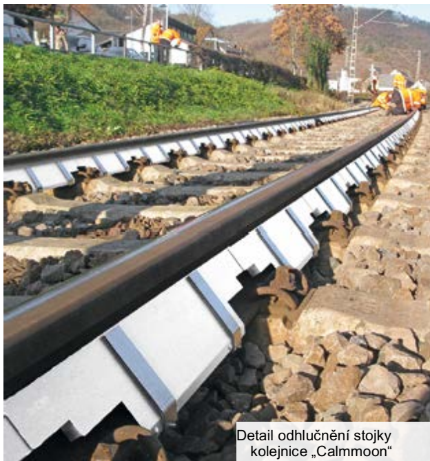
„Calmmoon“ (tichá) kolejnice v síti Deutsche Bahn
