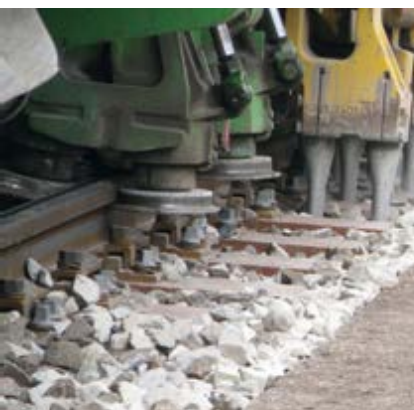
Podbíjení plochého pražce podbíjecím vlakem
