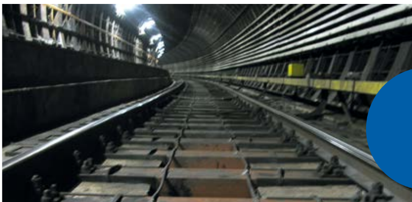
Vídeňské dráhy | FFU syntetický pražec uložený v tunelu v pryžové botce
