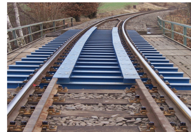
Železniční most přes řeku Vils ve Vilsbiburgu (Německo)
