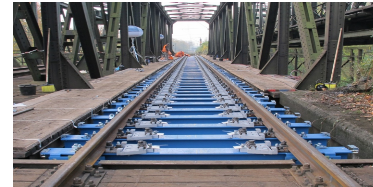
Železniční most s ocelovými mostnicemi v Magdeburgu
