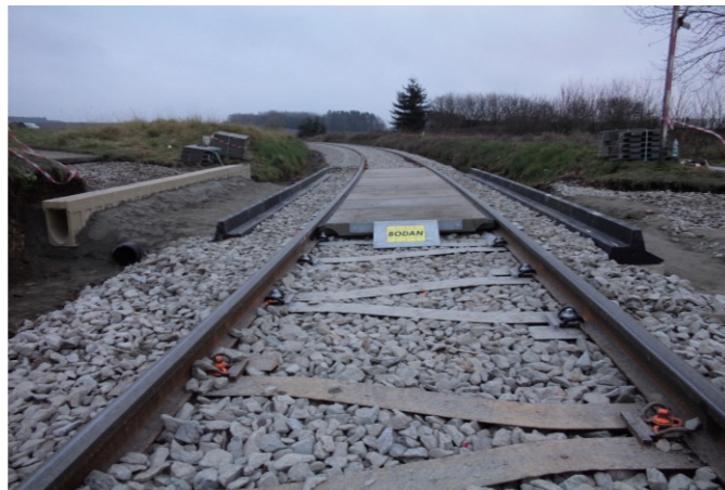
Přejezdová konstrukce BODAN Lom u Tachova ve fázi výstavby
