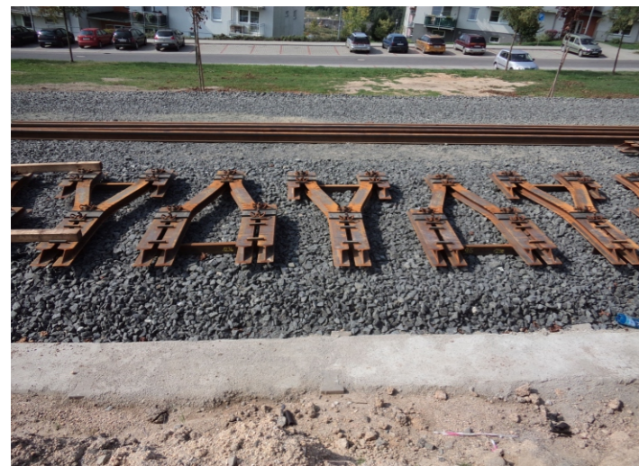
Pokládka ocelových pražců Y – splítka na tramvajové trati Liberec – Jablonec nad Nisou
